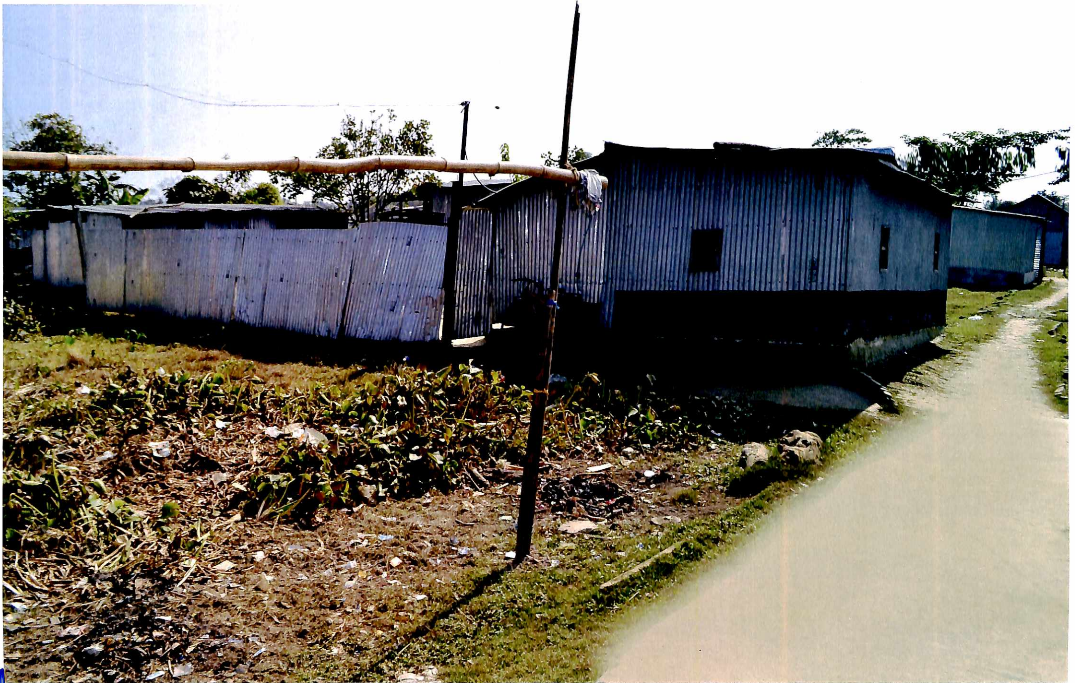
SLUM NAME --HOSPITAL PARA . WARD NO (18) .
